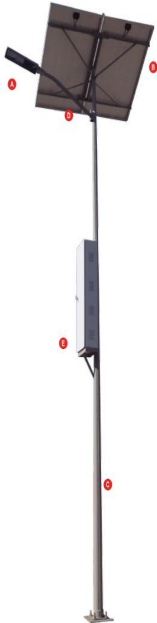
Alumbrado público con panel fotovoltaico
